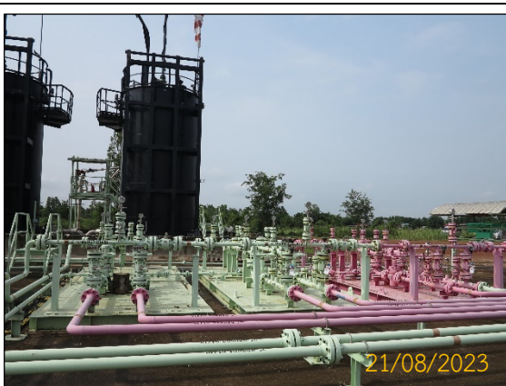
ภาพที่ 2.2-4 ระบบวาล์วบริเวณหัวบ่อ Christmas Tree และบริเวณ Choke Manifold
