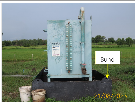
ภาพที่ 2.2-13 ถังเก็บน้ำมันดีเซล
