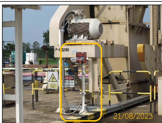
ภาพที่ 2.2-7 อุปกรณ์หยุดการทำงานฉุกเฉิน (OSD/ESD)
