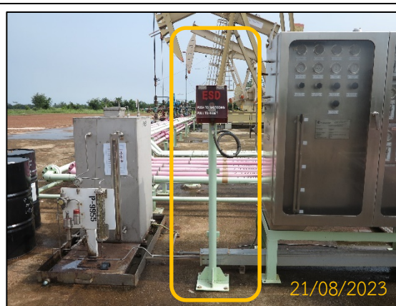
ภาพที่ 2.2-7 อุปกรณ์หยุดการทำงานฉุกเฉิน (OSD/ESD)
