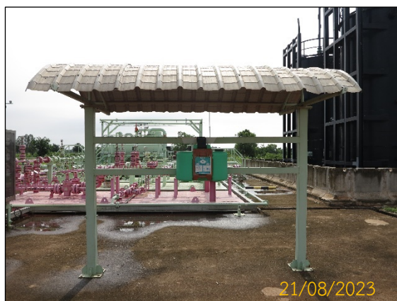
ภาพที่ 2.2-23 อุปกรณ์ล้างตาในพื้นที่ฐานหลุมผลิต
