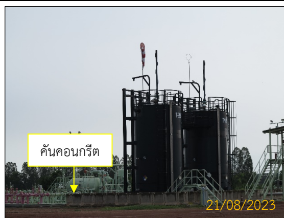
ภาพที่ 2.2-14 ถังเก็บน้ำมันดิบมีคัน คอนกรีตล้อมรอบ
