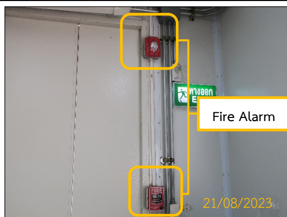
ภาพที่ 2.2-21 อุปกรณ์ป้องกันอัคคีภัยและสัญญาณเตือนภัยในพื้นที่ฐานหลุมผลิต
