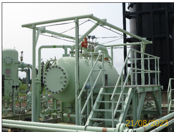
ภาพที่ 2.2-5 เครื่องแยกสถานะของเหลว-ก๊าซ (Production Separator)
