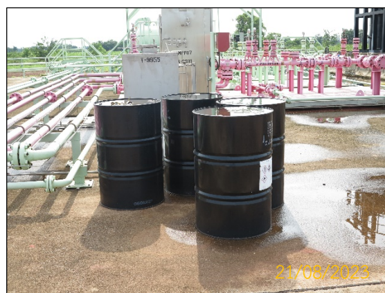
ภาพที่ 2.2-9 การจัดวางและติดตั้งอุปกรณ์การผลิต และสารเคมีบนพื้นคอนกรีตที่มีวางระบายน้ำล้อมรอบ
